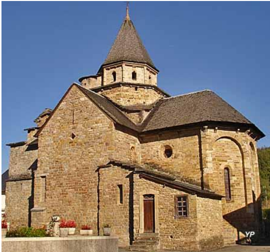
Eglise de l'Hôpital Saint-Blaise
